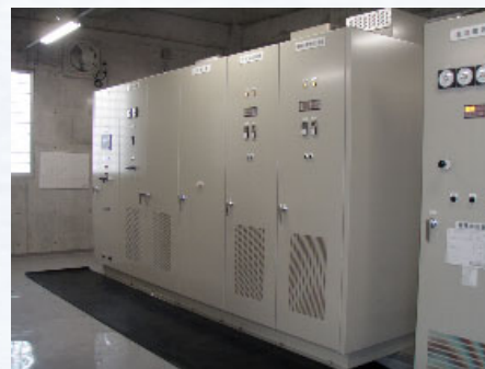
トンネル照明用非常用発電設備・受変電設備
