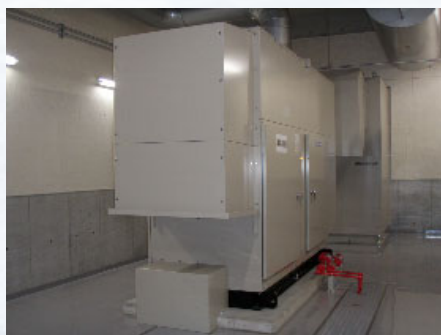
トンネル照明用非常用発電設備・受変電設備
